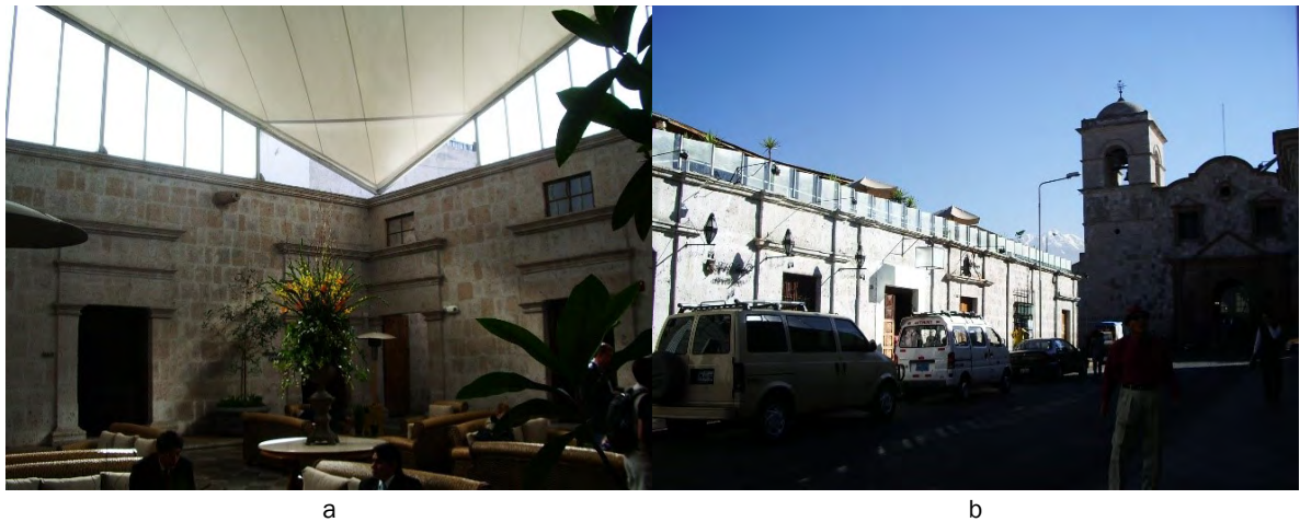
Figura 2. Estructuras ligeras en inmuebles del centro histórico de Arequipa. a. Cubierta de patio colonial. b. Paneles en fachada para ocultar terraza. Fuente: autora.
