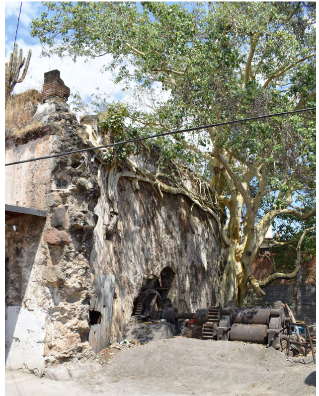
Figura 4. Casa del molino con vestigios del cárcamo y presencia de trapiche horizontal de tres mazas de hierro. Fuente: archivo personal Luis Alfredo Ayala Ortega, 2022.
