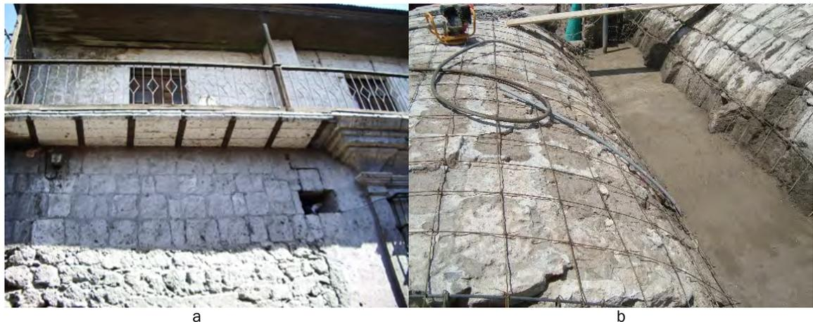
Figura 9. Estructuras mixtas. a. Balcón corrido con rieles ferroviarios sobre casa colonial arequipeña. b. Armado con malla de acero antes del hormigonado de bóvedas. Fuente: autora.
