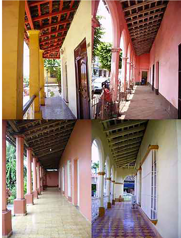
Figura 3. Imágenes de los pasillos en los portales de las viviendas tradicionales de San Andrés Tuxtla. Fuente: Propia.
