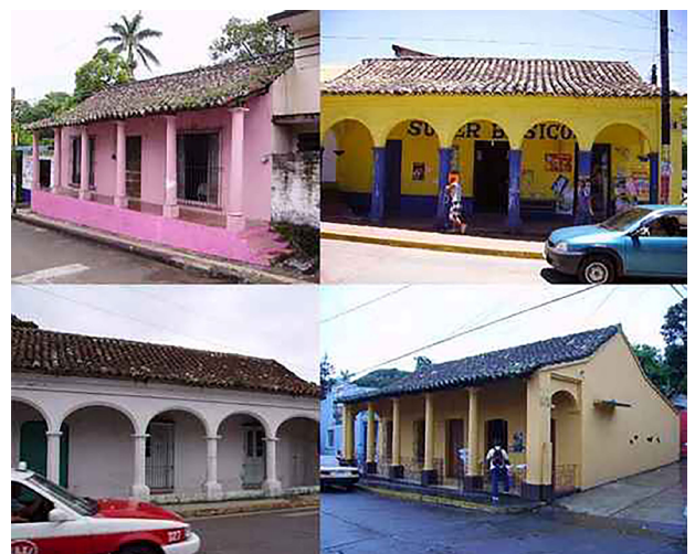
Figura 7. Imágenes de fachadas principales de la vivienda tradicional en San Andrés Tuxtla. Fuente: Propia.
