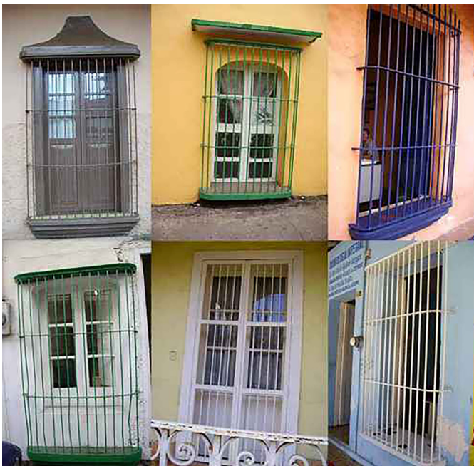
Figura 8. Fotografías de ventanas con protecciones en las fachadas principales de viviendas en San Andrés Tuxtla. Fuente: Propia
