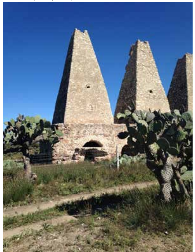
Figura 9 Hornos de fundición, en Mineral de Pozos Guanajuato. Fotografía por A. Monroy, (2014)
