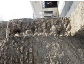
Figuras 16 y 17. Vista de las alturas de los muros de adobe exteriores, de 4.72 m; con un ancho de 0.60 m. Tamaño del adobe de 0.53 largo, x 0.28 de ancho x 0.10 m espesor. Fuente: Jiménez (2006-2007).
