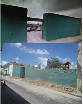
Figuras 20 y 21. Muro con acabado de cal arena, pintado. Se encontraba en proceso de demolición. Pertenece a la fachada sur del predio de Miguel Hidalgo No. 107 Ote. Fuente: Jiménez (2006-2007).
