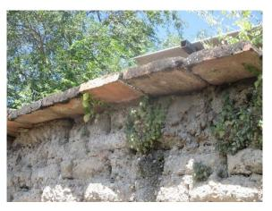
Figura 18. Ladrillo de barro rojo (0.25 x 0.15 x 0.07m), para cubrir la corona de los muros de tabique rojo. Fuente Jiménez (2006-2007).
