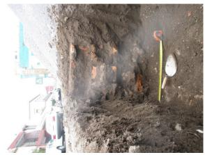
Figura 13. En esta imagen se aprecia el desplante de los muros de adobe sobre un cimiento de ladrillo 0.92 de altura, de profundidad -0.62 a -1.54 m, con un ancho de 0.62 m; los tamaños de los ladrillos son 0.46 x 0.29 x 0.5 m, y 25 x 15 x 0.7 m. Fuente: Jiménez (2006-2007).
