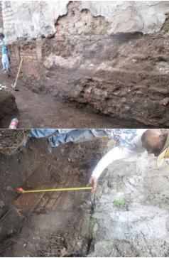
Figuras 28 y 29. Se excavó la zanja para la cimentación del muro norte del predio en los ejes 2-G y 2-H, que colinda con el muro sur de la casa Norte, y se liberó el registro del drenaje del cuarto de baño. En este muro se observó, en el perfil, una caja de registro hecho con ladrillo rojo con estas proporciones: 0.49 x 0.29 x 0.05 m, 0.40 x 0.29 x 0.05 m; y tabiques de 0.22 x 0.15 x 0.07 m. (que corresponden a los muros de los predios que están a los lados). Fuente: Jiménez (2006-2007).
