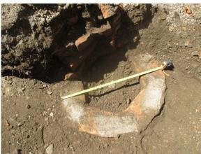
Figura 31. Base de un registro de drenaje de forma hexagonal, elaborado con tabique rojo.
