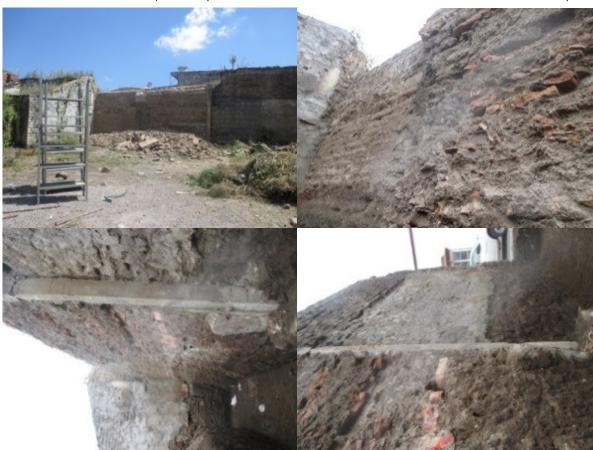
Figuras 32, 33,34 y 35 Vista del muro de adobe, el cual tiene una altura de 4.72 m; corresponde al muro Oeste de la casa Este, el cual se encontró modificado al colocar castillos de concreto para reforzarlo. Sus cimientos cuentan con un relleno de fragmentos de tabique y ladrillo con 0.92 m de altura, visibles en el eje de excavación de la letra I, en los ejes del 2 al 8.
