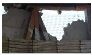
Figura 13. Este sector pertenece al muro de la cúpula. Por su mal estado tuvo que cambiarse todo. Puede verse el bastidor de madera con la malla plástica (PVC) rígida y el recubrimiento con caña de guayaquil chancada. En todo momento se consideró no usar torta de barro, por ser un material que contiene organismos que contribuyen a la destrucción de lo orgánico. Foto: F. Carbajal B.
