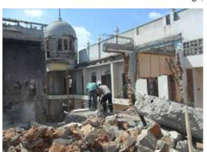
Figura 1. Demolición usando rotomartillo. Foto: F. Carbajal B.
