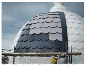
Figura 5. Colocación de teja asfáltica sobre superficie de diablo fuerte, previamente impermeabilizada con asfalto. Foto: F. Carbajal B.
