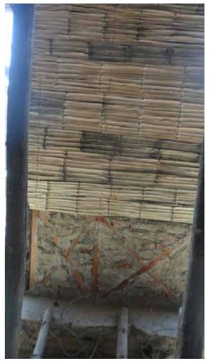
Figura 14. Módulo de bastidor de muro de quincha luego de su reparación. Puede verse el encañado, previamente curado contra insectos xilófagos, con caña de guayaquil, y en la parte inferior el muro de ladrillo que permite la estabilidad de éste. Foto: F. Carbajal B.
