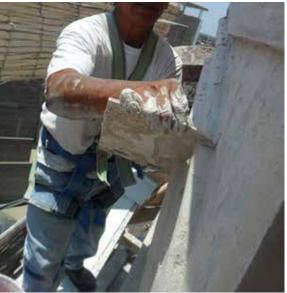
Figura 9. Restauración de moldura en la cúpula; puede verse el uso de una tarraja metálica.
