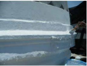
Figura 7. Colocación de banda de fibra de vidrio en la moldura de la base del domo. Foto: F. Carbajal B.
