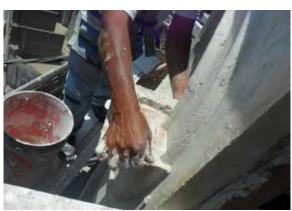
Figura 8. Restauración de una moldura vertical en la fachada. Foto: F. Carbajal B.
