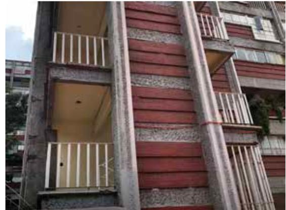
Figura 10: deterioros del concreto armado en escaleras de torres de vivienda en el CUPA. Fuente: archivo personal.
